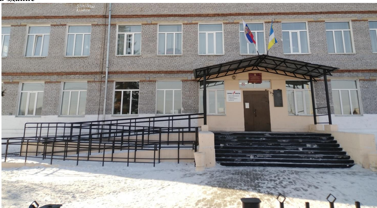
Фото № 3 Вход в здание
