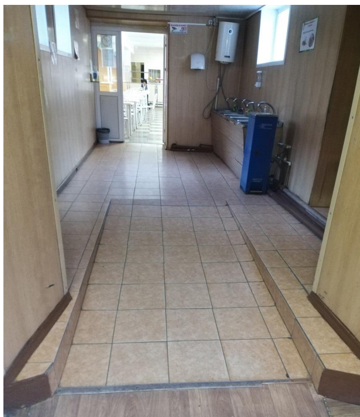
Санитарно-гигиенические помещения (вход в столовую)
